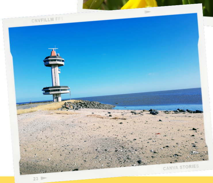
Achter de gascentrale
